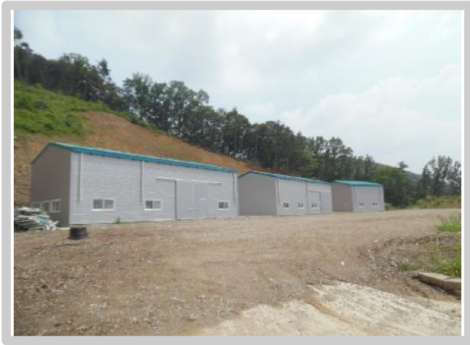
【본건 전경 및 제시외건물】
