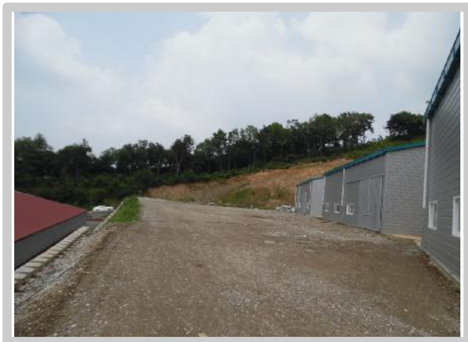
【본건 전경 및 제시외건물】
