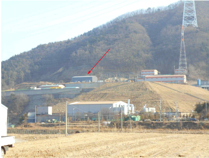
본건 및 주변 전경(1)
